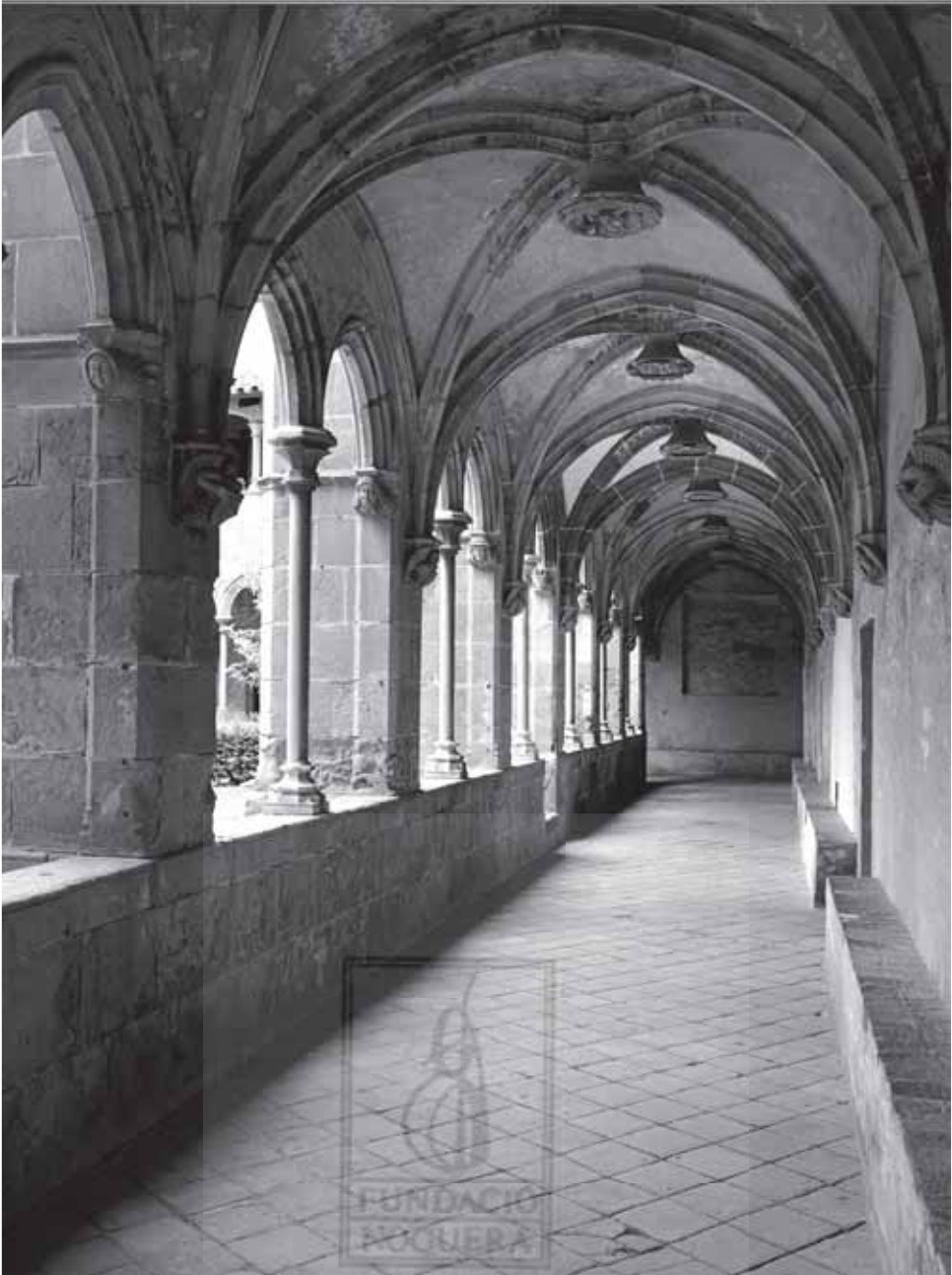
Galeria de tramuntana del claustre de Sant Jeroni de la Murtra. Fotografia: Antonio Guillén.
